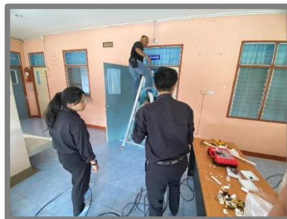
ดำเนินการควบคุมงานโครงการเพิ่มศักยภาพในการป้องกันชีวิตและทรัพย์สินของประชาชน ติดตั้งกล้อง CCTV รพ.สต.พิหารแดง อ.เมืองสุพรรณบุรี จ.สุพรรณบุรี (อยู่ระหว่างเดินท่อสายไฟ)
