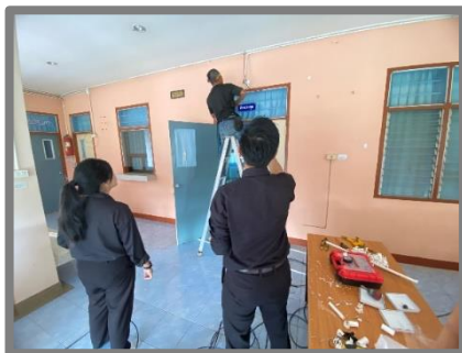
ดำเนินการควบคุมงานโครงการเพิ่มศักยภาพในการป้องกันชีวิตและทรัพย์สินของประชาชน ติดตั้งกล้อง CCTV รพ.สต.พิหารแดง อ.เมืองสุพรรณบุรี จ.สุพรรณบุรี (อยู่ระหว่างเดินท่อสายไฟ)
