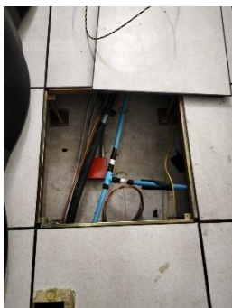
ดำเนินการควบคุมงานติดตั้ง เดินท่อวงจรชุด Smoke , Shutdown Air ,Main AC.Power ใต้พื้น Raise Floor ณ ห้อง Data Center
