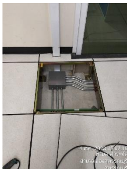
ดำเนินการควบคุมงานติดตั้ง เดินท่อวงจรชุด Smoke , Shutdown Air ,Main AC.Power ใต้พื้น Raise Floor ณ ห้อง Data Center
