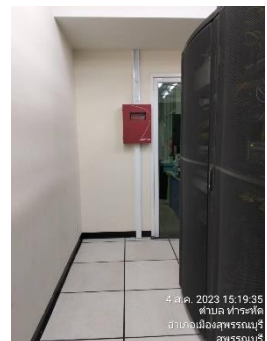
ดำเนินการควบคุมงานติดตั้ง เดินท่อวงจรชุด Smoke , Shutdown Air ,Main AC.Power ใต้พื้น Raise Floor ณ ห้อง Data Center
