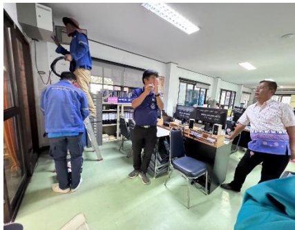
ดำเนินการลงพื้นที่ควบคุมงานการเดินสายไฟเบอร์ออฟติก ที่ อบต.หนองหญ้าไซ ให้เชื่อมโยงระบบกล้องโทรทัศน์ วงจรปิด (cctv) โดย อบต.จัดซื้อเครื่องคอมพิวเตอร์เอง
