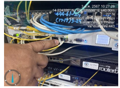
ดำเนินการลงพื้นที่ตรวจสอบเช็ค Router กล้องที่ สภ.บางตาเถร , สภ.สองพี่น้อง เนื่องจากสัญญาณภาพไม่ส่งไปที่เครื่องบันทึกสำนักงานใหญ่
