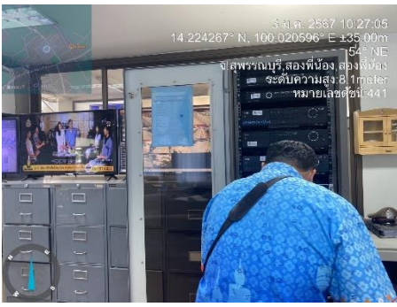
ดำเนินการลงพื้นที่ตรวจสอบเช็ค Router กล้องที่ สภ.บางตาเถร , สภ.สองพี่น้อง เนื่องจากสัญญาณภาพไม่ส่งไปที่เครื่องบันทึกสำนักงานใหญ่
